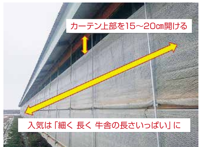
写真2 牛舎側面のカーテン上部を開けて入気する
