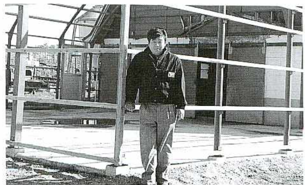
現在、作業効率を考えた飼調整室を建設中です
