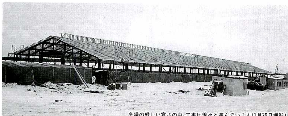
冬場の厳しい寒さの中、工事は着々と進んでいます(1月25日撮影)
