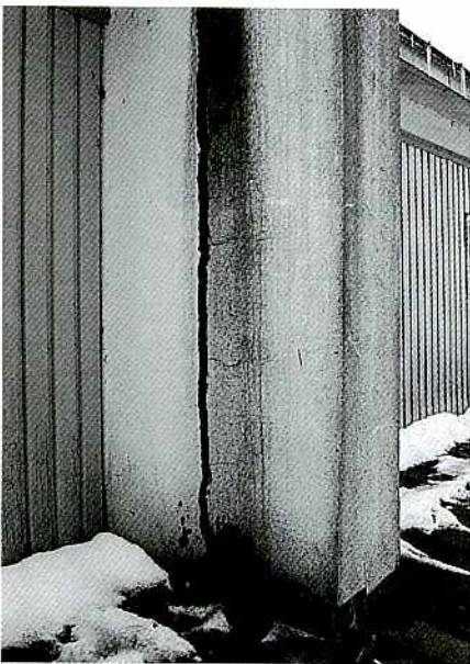
住宅の集合煙突が割れた
