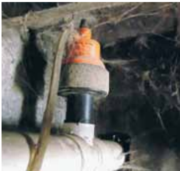
写真1 清掃されていない調圧器
