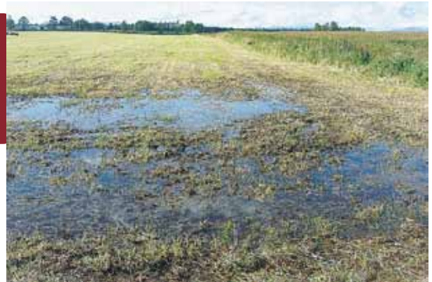
写真1 排水不良のほ場。なかなか水が引かない状態が続いた
